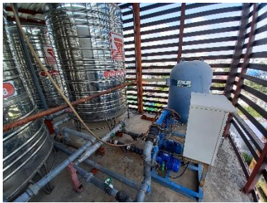
ถังเก็บน้ำชั้นดาดฟ้า และ Booster Pump
